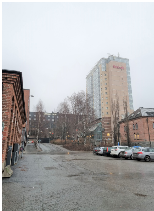
Figur 32. Siktlinje från kajområdet mot fastigheten Brage 8 och Renmarksplanadens kvarvarande portal.
