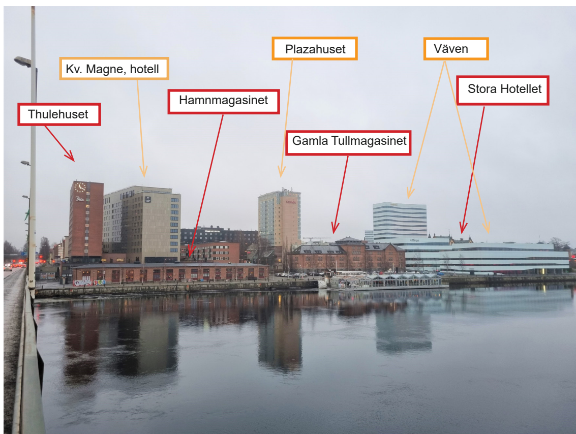
Figur 19. Foto från Tegsbron mot Västra Strandgatan.
