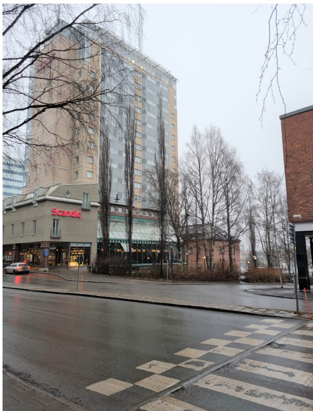
Figur 31. Siktlinje från Storgatan mot fastigheten Brage 8 samt Gamla Tullmagasinet och älven.
