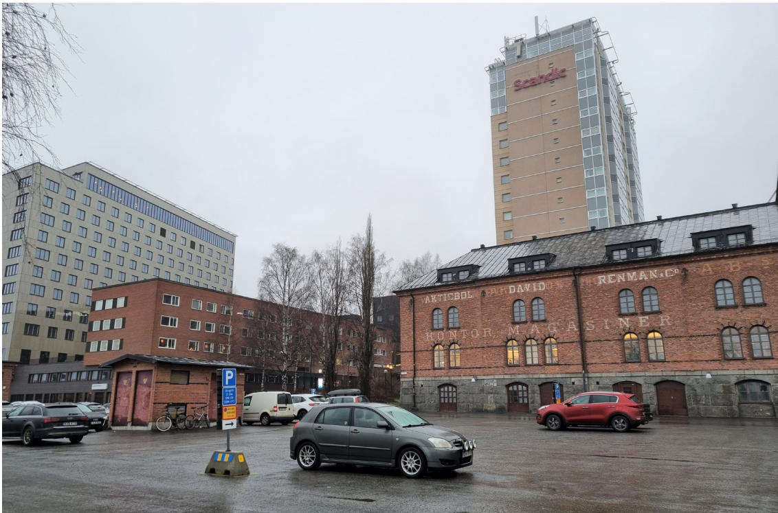
Figur 23. Vy från kajområdet mot gamla Tullmagasinet som syns till höger i bilden. Fastigheten Brage 8 syns till vänster om gamla Tullmagasinet. Plaza huset sticker upp bakom tullmagasinet.
