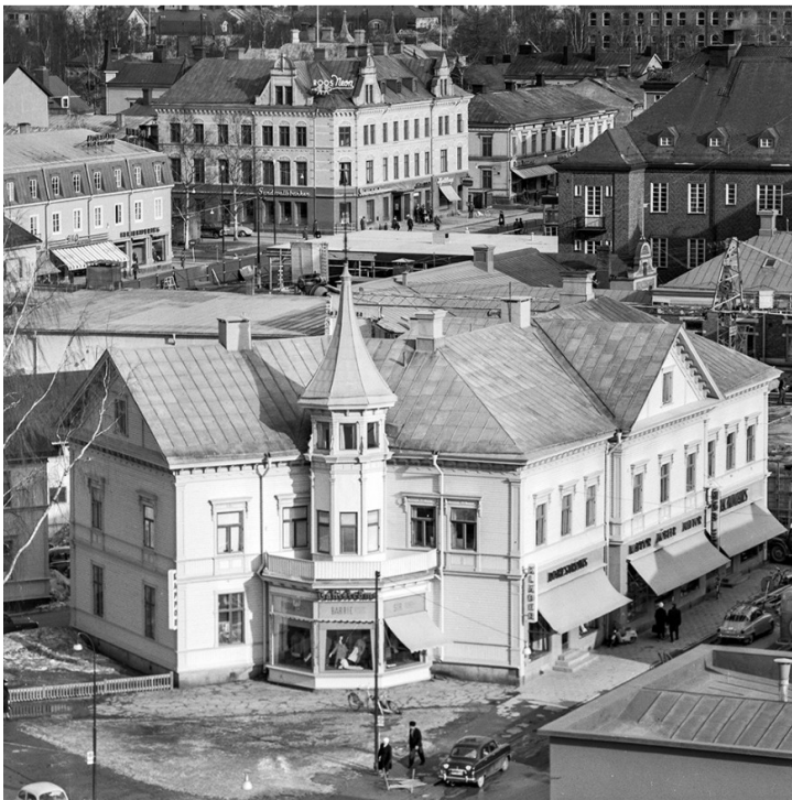
Figur 15. Historiskt fotografi taget från det då nybyggda Thulehuset ner mot Storgatan och nuvarande Renmarkstorget. Källa: Umeå kommun - foton från det historiska Umeå.
