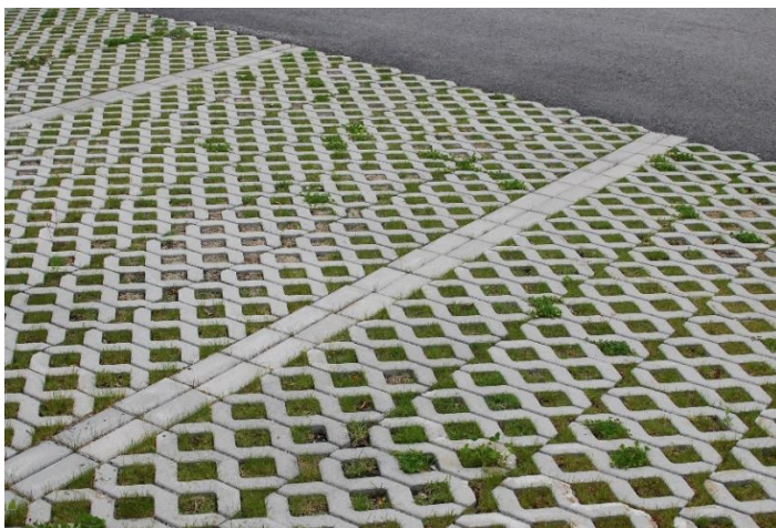
Figur 22. Exempel på vattengenomsläpplig beläggning på parkering. Foto: Sweco
