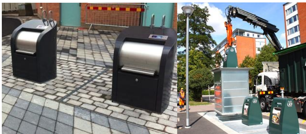
Figur 8 Inkast till underjordsbehållare (t.v.). Tömning av underjordsbehållare (t.h.). Foto: PWS AB (t.v.). San-Sac AB (t.h.)
