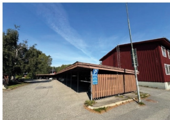
Kv. Korallen 10. Parkeringsplatser med skärmtak, carport.
