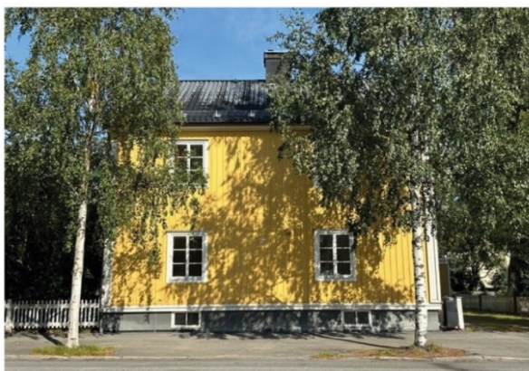
Kv. Korallen 2. Skolgatan 1B. Byggår: 1933
