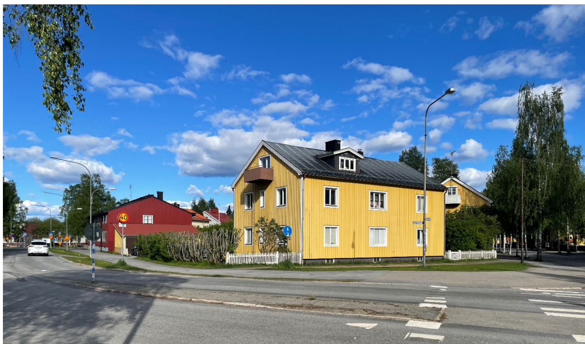
Figur 9 Vy mot planområdet från korsningen Signalvägen-Skolgatan.
