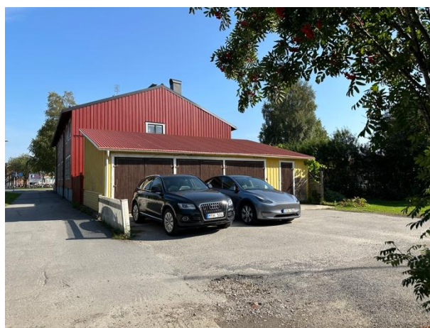
Garagelänga tillhörande fastigheten.
