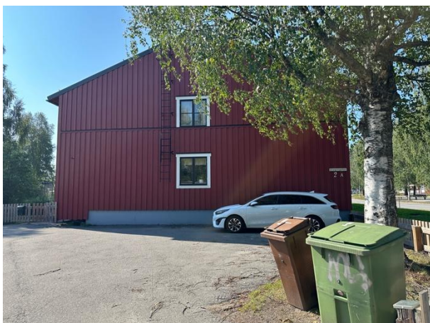
Parkeringsyta intill garagelänga. Ytan är beklädd med asfalt.
