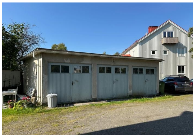
Kv. Korallen 6. Garagelänga på innergård.
