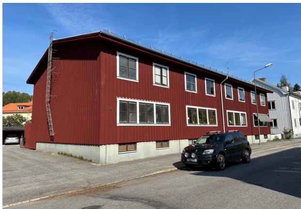
Kv. Korallen 5. Hantverkaregatan 3A, 3B, 3C, 3D. Byggår: 1976. 4st 4 rums radhus på ca 116 m 2 . Privata fastighetsägare
