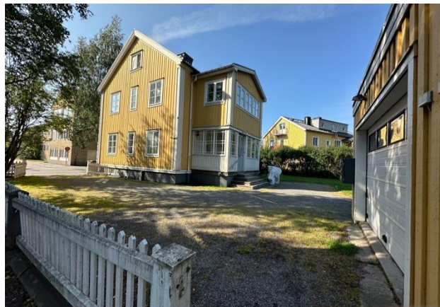
Kv. Korallen 2. Vy mot innergård med tillhörande garage.
