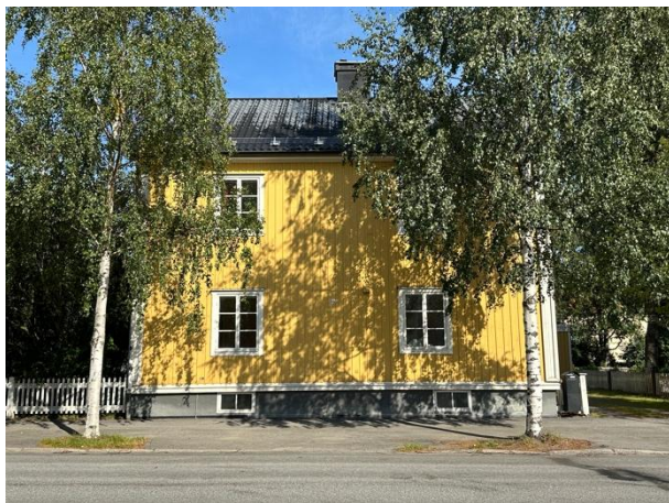
Fasad mot Skolgatan. Notera hur flytt av två fönster i bottenvåning och 1 tr. i samband med 1970-talets invändiga rockad har påverkat symmetrin.
