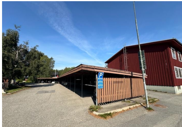
Kv. Korallen 10. Parkeringsplatser med skärmtak, carport.
