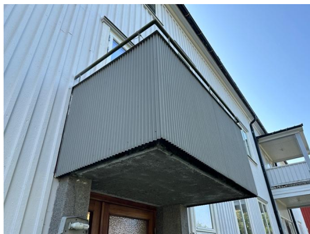
Balkonger med sinuskorrugerad plåt. Originalport.
