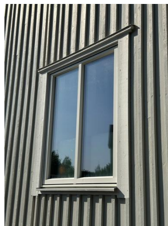
Fönsterbyte till enlufts-fönster med fuskpröjs och plåtbeklädnad.
