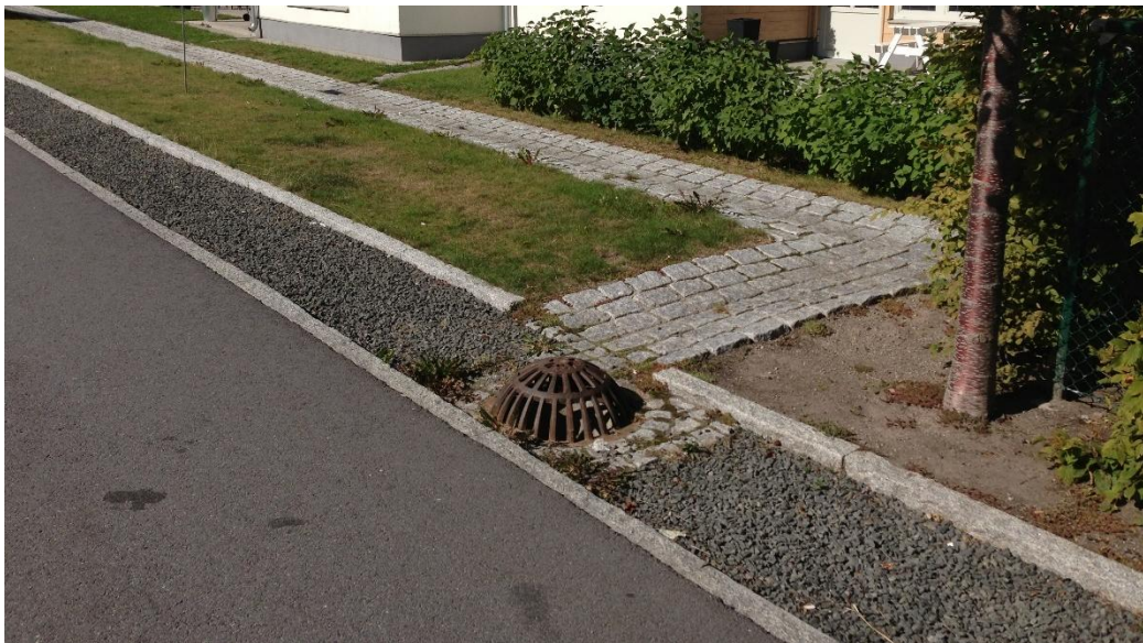
Figur 28. Figuren presenterar ett förslag på hur ett infiltrationsstråk/krossdike som inte är gräsbeklätt kan utformas (WSP, 2019).
