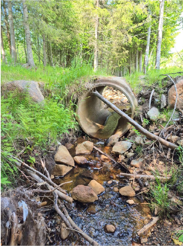
Figur 19. Vandringshinder 3 består av en kort betongtrumma som används som en traktoröverfart.
