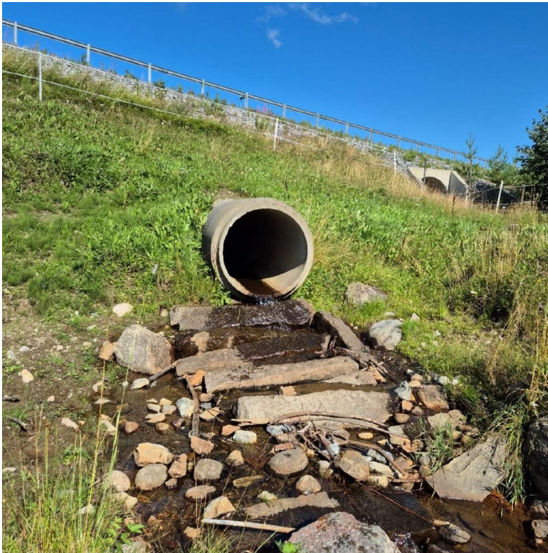
Figur 17. Vandringshinder 1 består av en vägtrumma under landsvägen längst ned på sträcka 1. Vid denna trumma startade biotopkarteringen.
