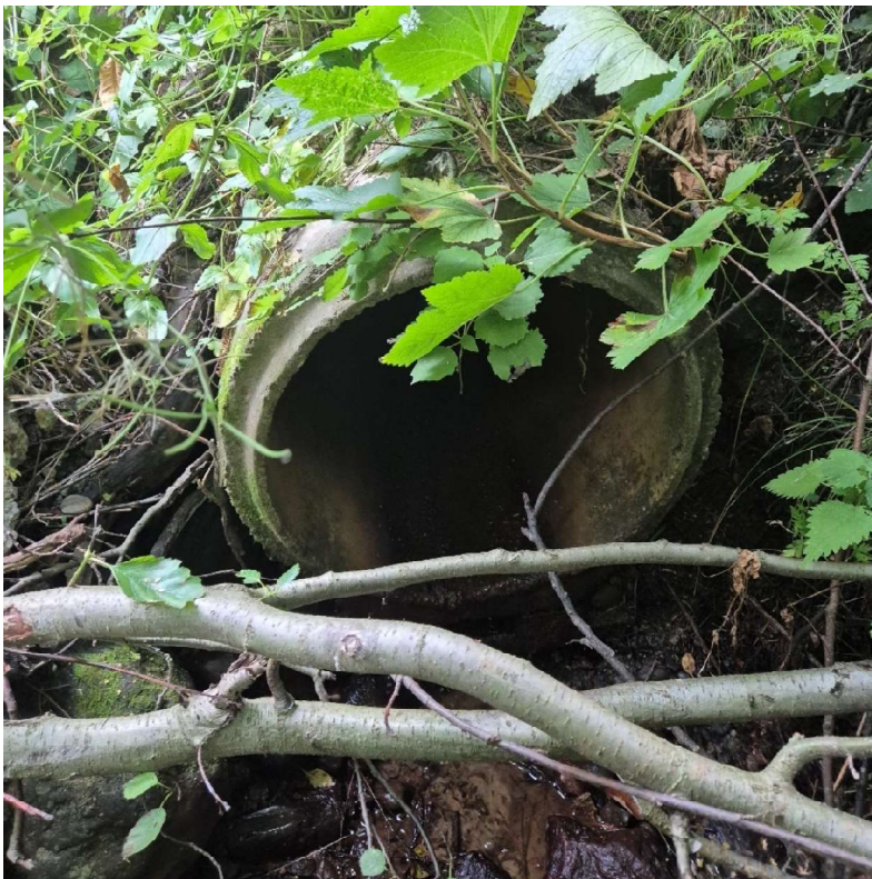
Figur 21. Vandringshinder 5 består av en vägtrumma under bilväg. Otillgänglighet på grund av växtlighet gör det svårt att få bra bilder på trumman.
