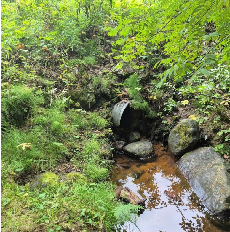
Figur 20. Vandringshinder 4 består av en vägtrumma under bilväg. Otillgänglighet på grund av växtlighet gör det svårt att få bra bilder på trumman.
