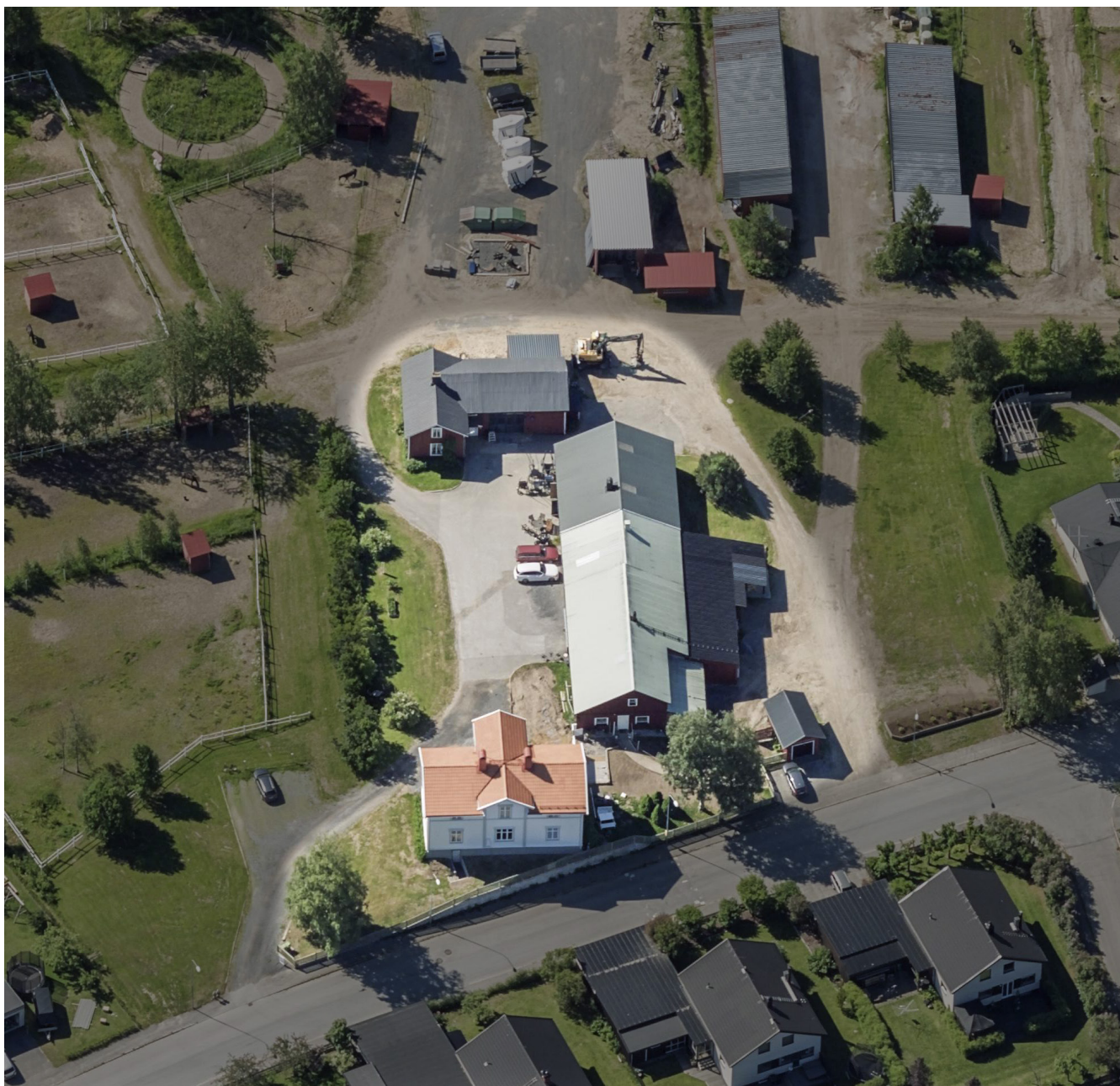
Figur 17. Kulturhistorisk värdefull byggnad samt tillhörande ladugård och uthus inom fastighet Österteg 2:78.
