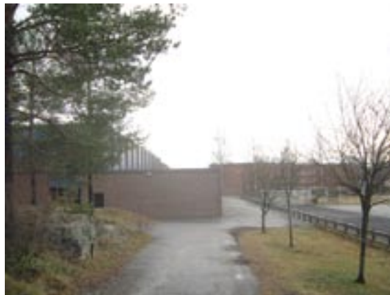
Idrottshallens entrésida mot idrottsplatsen.
