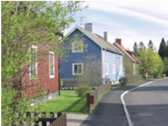
Renoverad egnahemsbebyggelse. 30-tal.
