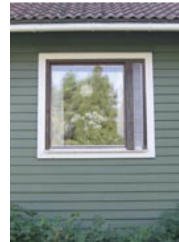
Enluftsfönster med sidställd vädringslucka, 60-tal.
