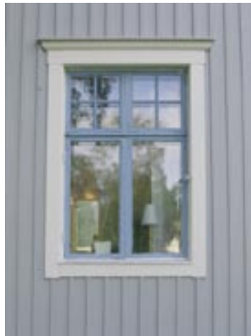
Korspostfönster, tätspröjsad överdel, 20-tal.
