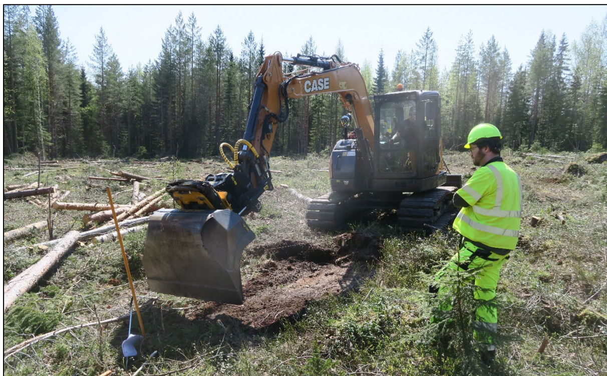
Fig. 6. Maskinschaktning vid område 3 i samband med etapp 2. Fredrik Pada och Johan Hedström i bild. Bild VBM DB 927_150.
