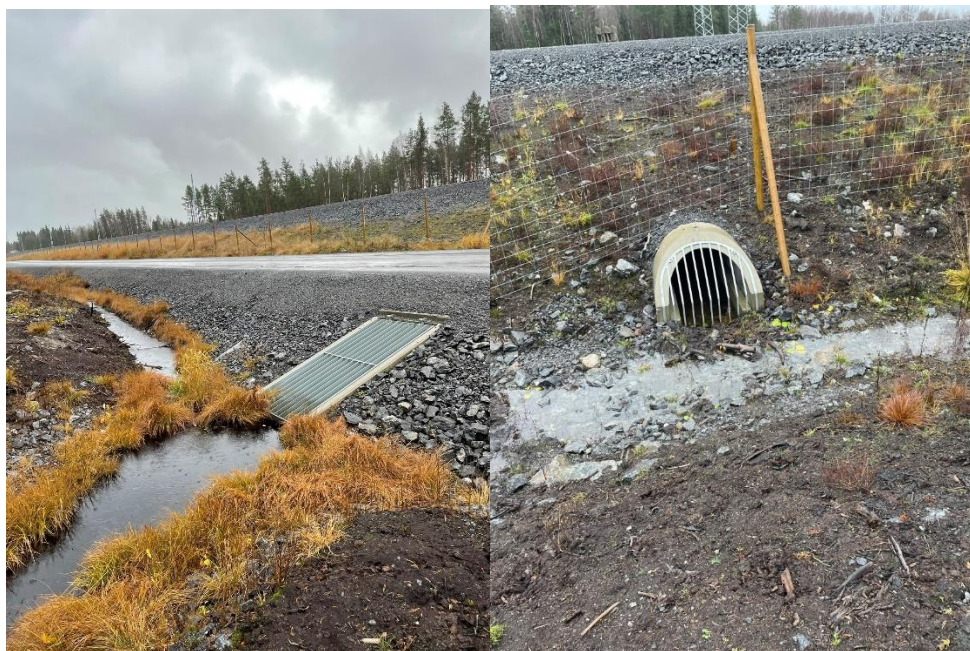
Figur 1.19 Bilder av Norrbotniabanan kulvertarnas inlopp (Källa: Umeå kommun. Kulvert 1a till vänster; kulvert 2 till höger)
