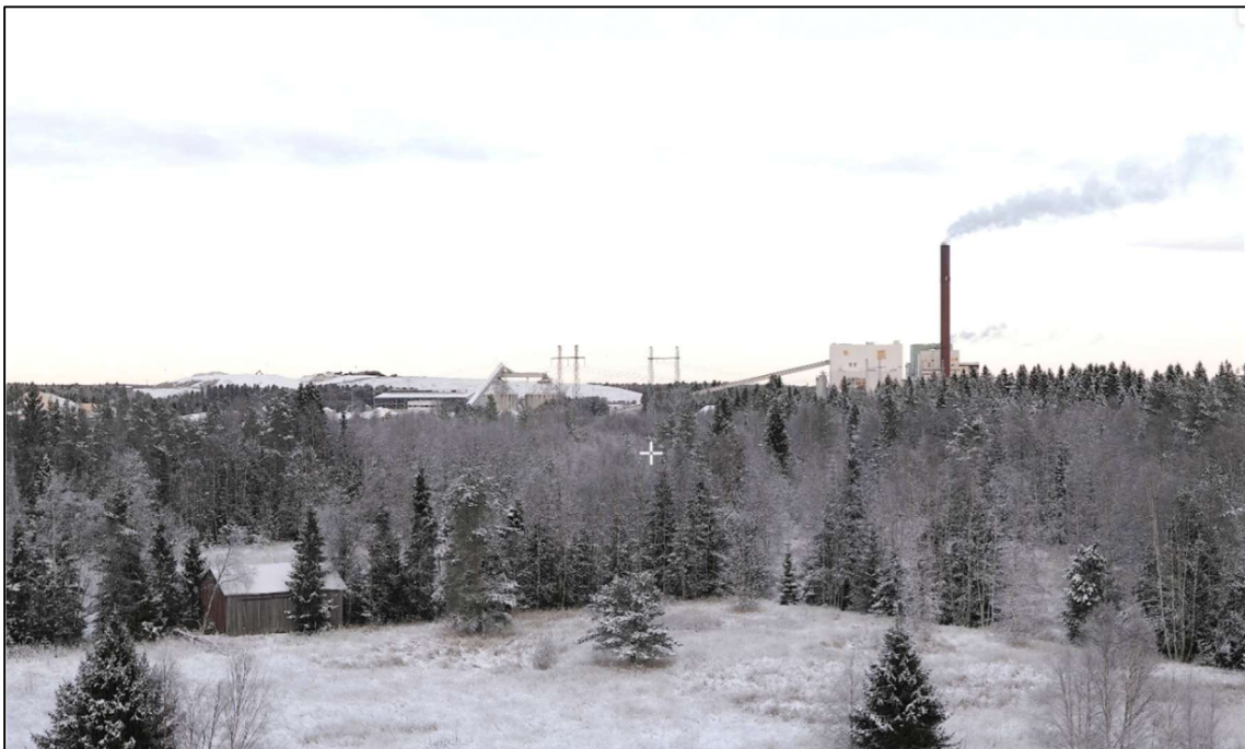
Figur 10. Detaljvy från drönarflygning (50 m höjd) över Anumark som visar den visuella kopplingen mellan industriella landskapselement. I bildens centrala del syns skorstenen från Umeå Energis kraftvärmeverk (KVV) samt Däva (DAC) deponier.
