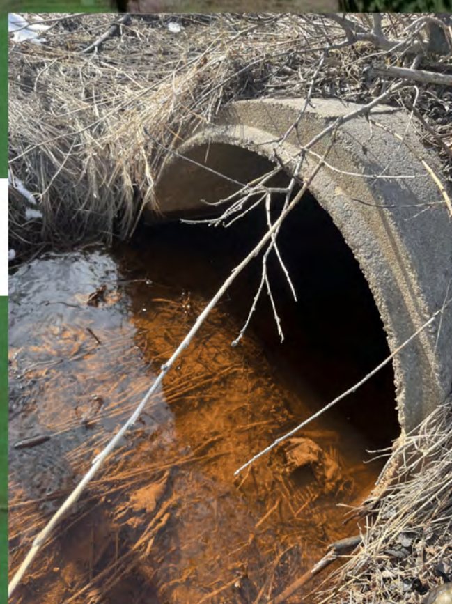
Trumma under E4 D: 1000mm
