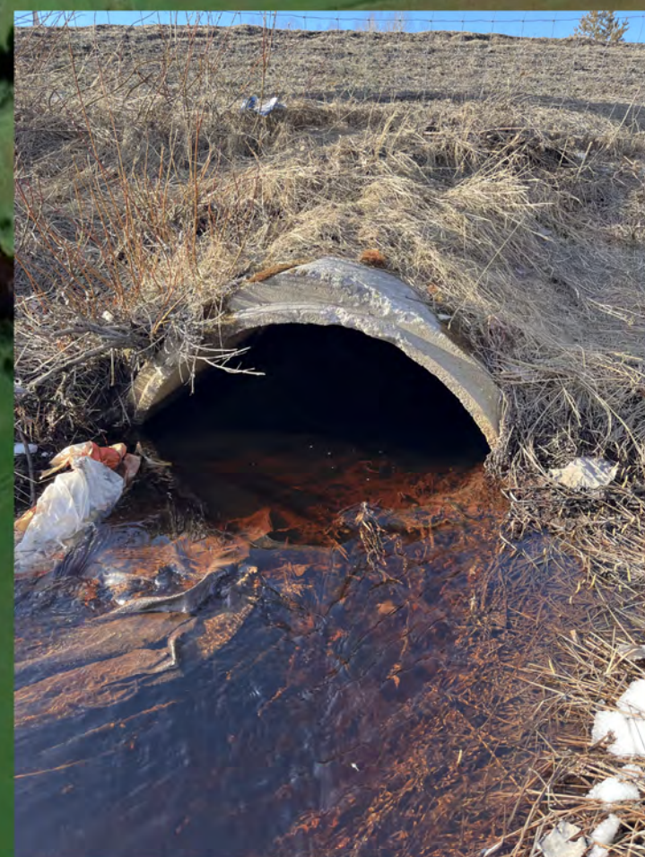
Trumma under E4 D: >1000mm
