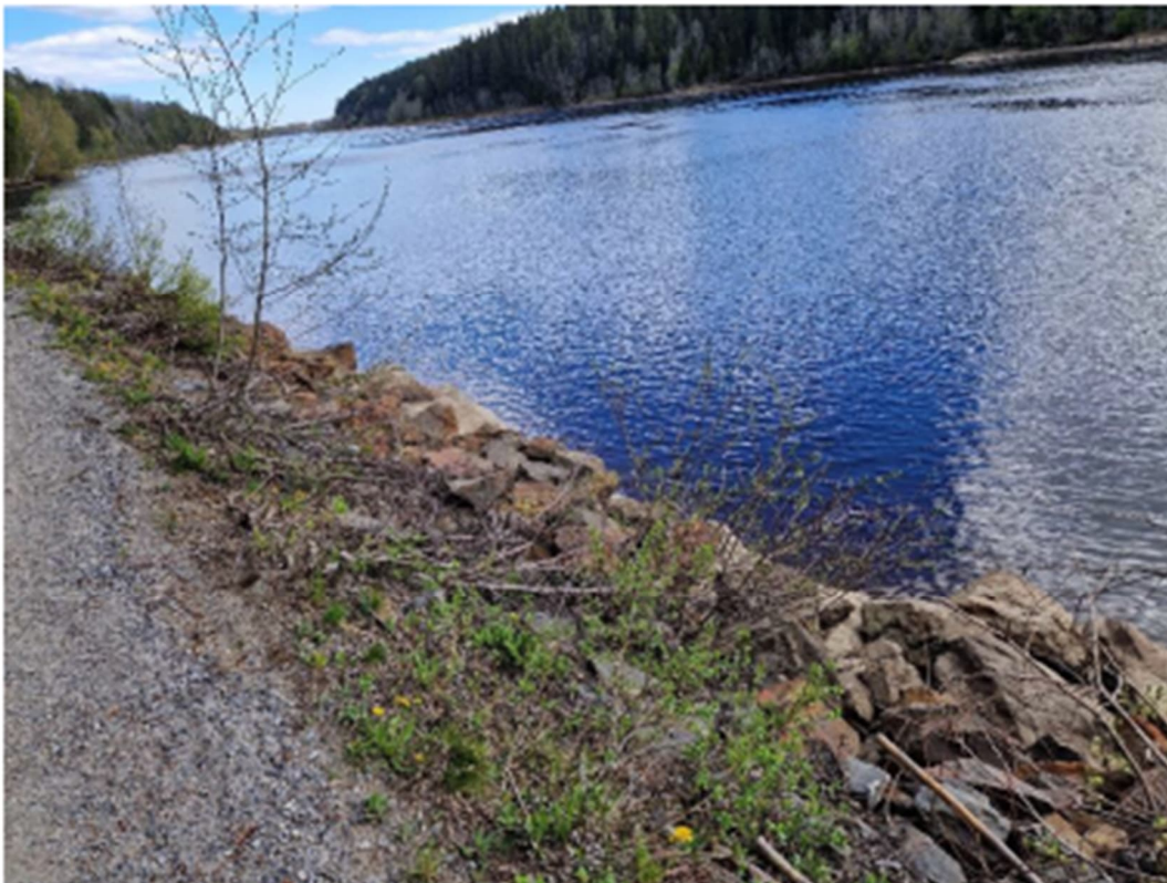
Figur 4-11. Erosionsskydd av sprängsten mellan km 5/000–5/500.
