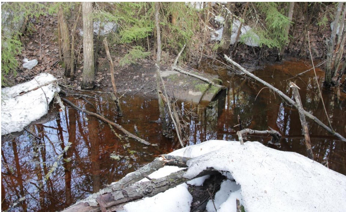
Figur 15. Punkt 2. Utlopp dagvattenledning 1000 mm betong vid Kolbäcksvägen. Stillastående vatten. Mottagande dike har högre dikesbotten längre nedströms vilket kan vara en av flera orsaker till dåmt utlopp.
