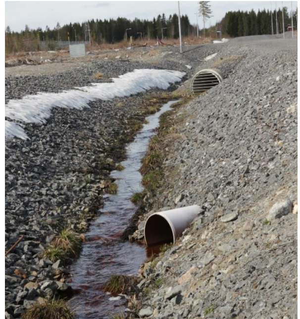
Figur 24. Punkt 10b. Dagvattenutlopp (övre, med galler) och utlopp för pumpstationens nödbredd (nedre). Rinnande dagvatten.
