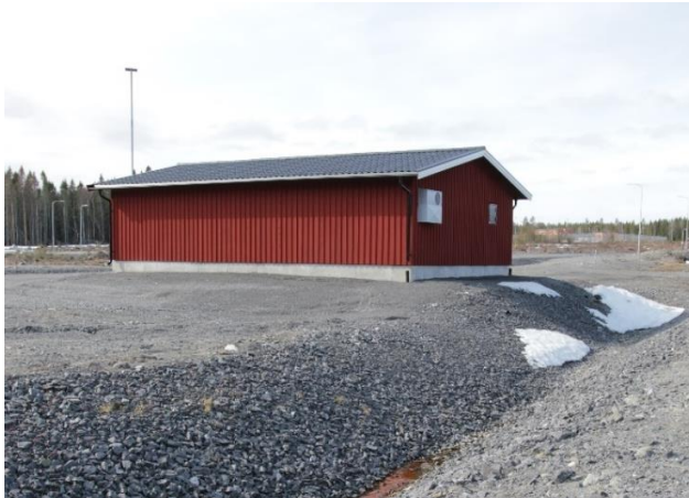
Figur 23. Punkt 10a. Pumpstation byggd i tidigare etapp.
