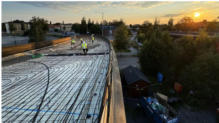
Bild: Byte av värmeslingor och reparationsarbeten Sjukhusbacken.
