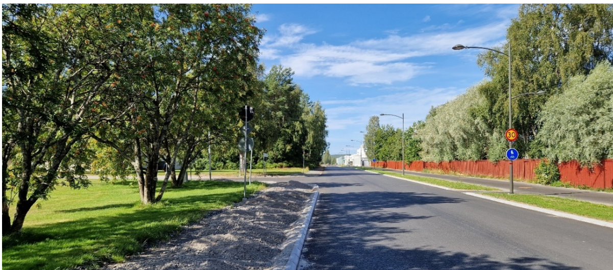
Figur 12: Bild över del av Bölevägen, augusti 2025, vy mot väster. Trottoar och träd till vänster i bild är en del av fastigheten Aspgärdan 19.
