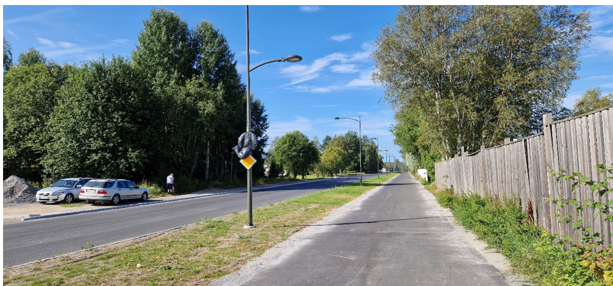
Figur 15: Separerad gång-och cykelväg vid Bölevägen, augusti 2025. Vy mot väster.
