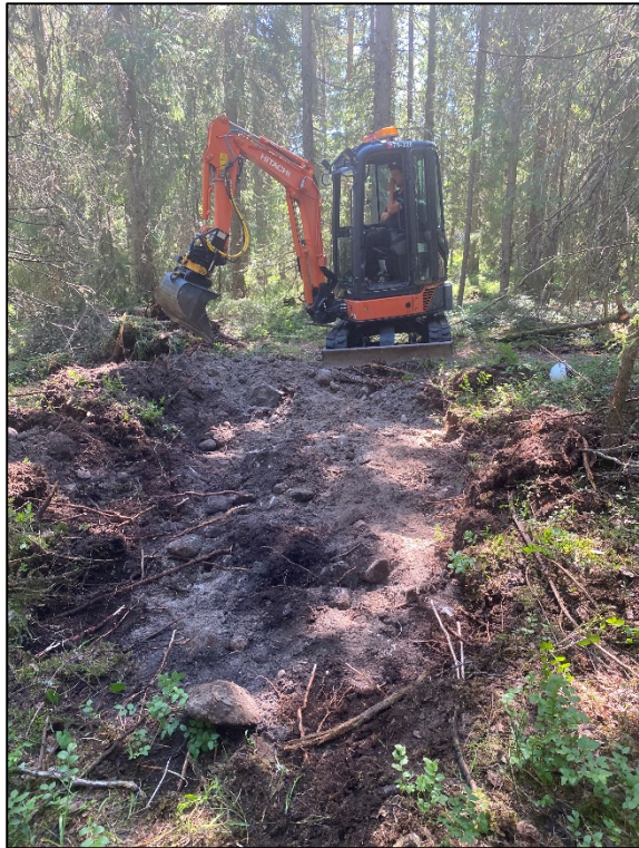
Figur 2. Schakt 6. Grävmaskinist var Fredrik Pada, Norrproffs och Västerbottens Traktortjänst AB.
