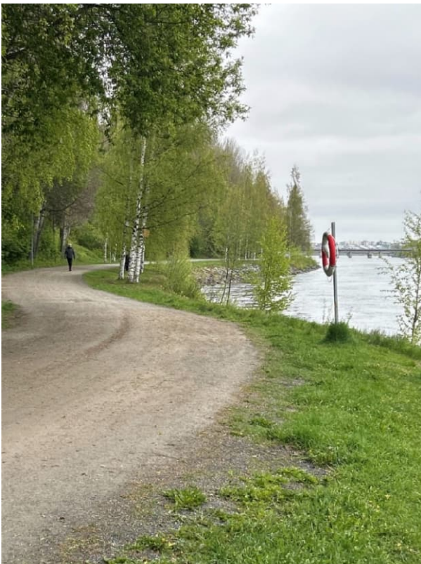
Figur 4-15. Nedre slänten mot älven, ringa erosion, exempel från ca sektion 0/900.
