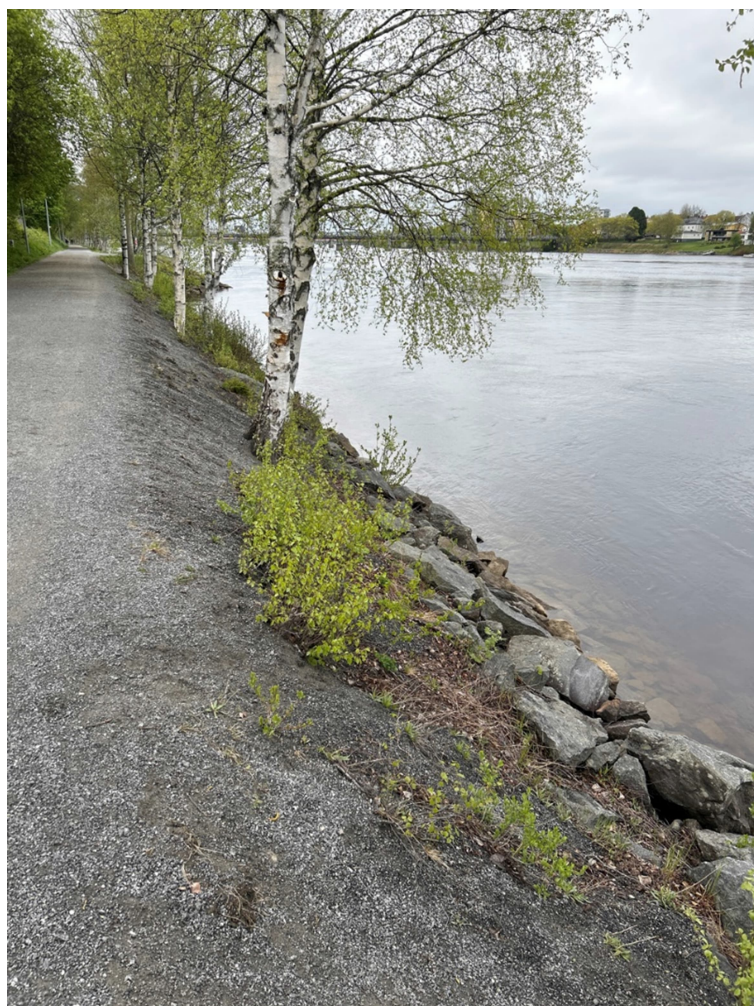
Figur 4-11. Foto från platsbesök som visar sprängsten utlagd i strandkanten kring km 0/400.
