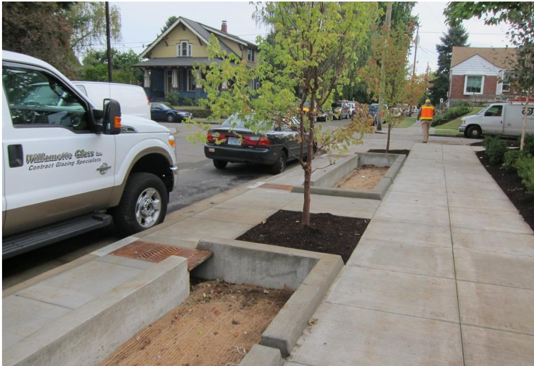
Figur 11: Exempel på dagvattenmagasin under uppförande mellan gata och trottoar.
