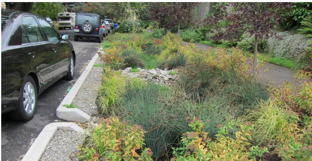
Figur 10: Exempel på dagvattenmagasin mellan gata och GC-väg.
