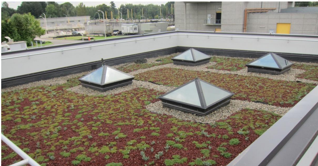
Figur 14: Nyanlagt grönt tak.
