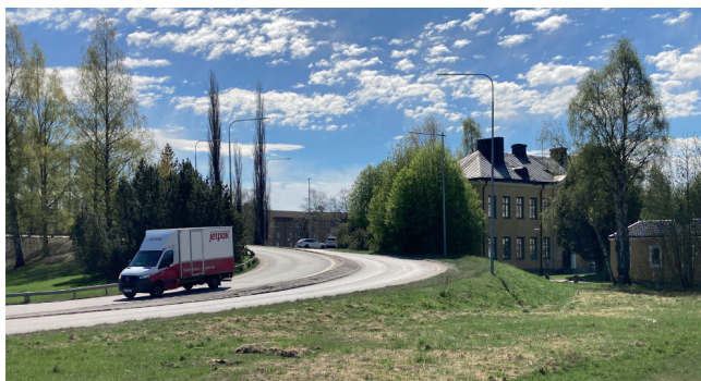
Avfartsramp på Västra Esplanadens västra sida med det f.d. militärsjukhuset till höger i bild. Foto: White arkitekter
