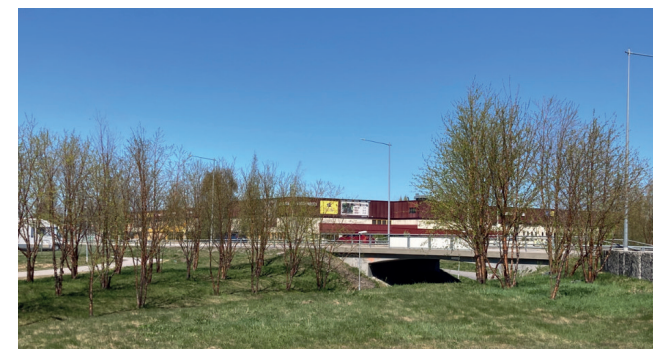
Västra delen av programområdet med gångtunnel under Ytterhiskevägen. Foto: White arkitekter
