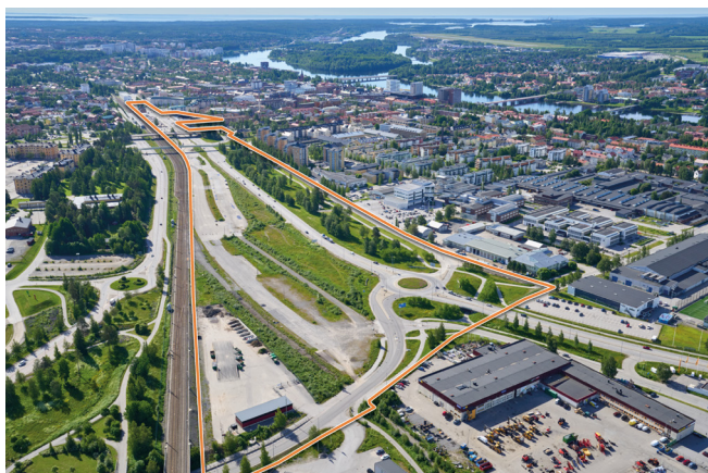
Flygvy från nordväst över planområdet. Orange linje visar ungefärlig gräns för programområdet.
