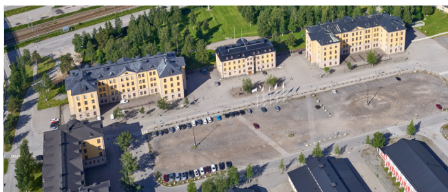
Byggnader inom f.d. Västerbottens regemente (I20). Regementsbyggnaderna utgör ett viktigt fondmotiv i staden.
