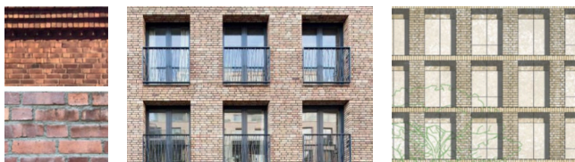
Tegelreferenser och fasader med tydlig modulindelning.
