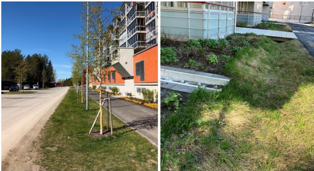
Figur 25. I figuren visas två exempel på hur ett svackdike kan utformas inom kvartersmark. I den högre bilden ses även en bro som möjliggör passage över svackdiket även om diket skulle stå med vatten (WSP, 2019).
