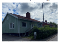
Putshusbebyggelse på Djupålsvägen, Haga Umeå kommun.
